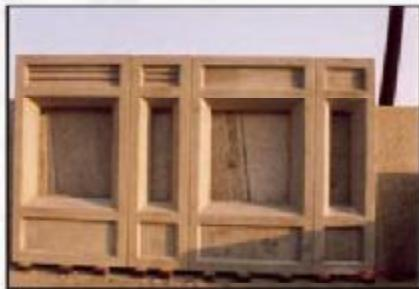
این سیستم سازه‌ای، مشکل از دیوارهای توپر بتن مسلح است که بنا به ضوابط و نیازهای معماری پروره طراحی و تولید می‌شود. منقطع عرضی این دیوارها ممکن است در طول ارتفاع، با توجه به نیاز به تامین بازشو یا طلاقجه، متغیر باشد. در دو انتهای دیوارها نیم‌دایره‌های توخالی به نحوی تامین شده‌است که با قرارگیرنده در پانل دیواری در کنار یکدیگر، امکان تعیه کلاف را فراهم می‌کند. سقف این سیستم از نوع سقف‌های با هسته توخالی بتن مسلح پیش ساخته می‌باشد و لازم است کلیه ضوابط مربوط به طرح و اجرای آن‌ها مدنظر قرار گیرد.
