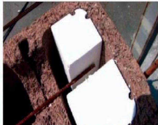
عنوان قالب عایق ماندگار به شماره رو. لذا با بررسی‌های به عمل آمده در زمینه رفتار این قالب‌ها و همخوانی آن با روند اجرای ساختمنهای با سیستم دیوار بازی، روش اجرای سازه‌های بتن مسلح با قالب عایق ماندگار از جنس این بلوکها به تائید مراکز رسید.
