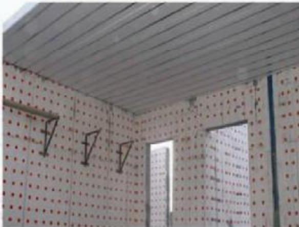
این روش اجرا یکی از انواع شیوه های اجرای سیستم ICF می باشد. در این روش قالب های ماندگار بصورت پائل های مستطیلی در کارخانه تولید و به کارگاه منتقل می شوند. این پائل ها مشکل از دو لایه ورق پلی استایرن، مش میانی و آرماتور های خربزی برای نگه داشتن آرماتور های افقی و عمودی تعییه شده می باشد.
