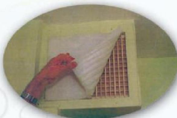
"مسدود کننده دریچه کولر از جنس فوم پلی اتیلن"، با خرارت گرفتن بر روی دریچه های کولر، در کاهش میزان تعویض هوا از طریق دریچه های کولر در فصول سرد سال تأثیر قابل ملاحظه ای ایجاد می کند و لذا باعث کاهش مصرف انرژی در ساختمان می گردد.
