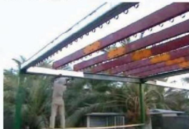
جاوگذاری می‌شوند. محل اتصال پیچ‌ها از قبل در ورق‌ها تعیین شده و سوراخ کاری شده است. در مرحله بعد ورق‌های میانگذار به سنتون جوش داده و آماده انتقال به کارگاه می‌شوند. از همین روش برای اتصال
