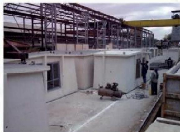
به دلیل اینکه مصالح مورد استفاده در این سیستم ساختمانی، بتن و فولاد معمولی می باشد، لذا عملکرد این سیستم در خصوص انرژی، حریق و آکوستیک مشابه عملکرد سازه های بتن مسلح مرسوم بوده و کلیه تمهیداتی که در مورد آن ها به کار گرفته می شود، می باشد در مورد این سیستم نیز رعایت شود.
