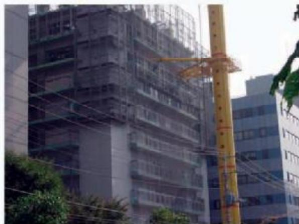
۱- استفاده از سیستم سازه‌ای R-PC به عنوان قاب خمشی بتن مسلح پیش‌ساخته با اتصالات غلافی (NMB) و بتن درجه، مشروط بر رعایت کلیه ضوابط آئین نامه ACI ۵۵۰، IR-۰۱ رعایت ضوابط متوسط یا ویژه مطابق با استاندارد ۲۸۰۰ رعایت ضوابط مربوط به آن) به شمار می‌رود و به کارگیری آن در کلیه پهنه‌های لرزه‌خیزی کشور بالامانع است.
