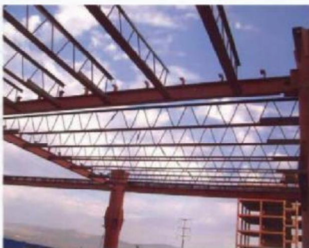
طريق دیافراگم صلب سقف به سیستم قائم باربری جانبه (دیوار برشی بتون مسلح) تأمین خواهد شد. اتصال تیرچه‌های کریست به بتنهای پیرامونی به صورت پیچی می‌باشد. آرماتور گذاری دال بتون مسلح مطابق با ضوابط مربوط به سقف‌های تیرچه-بلوک مطراحی می‌شوند.
