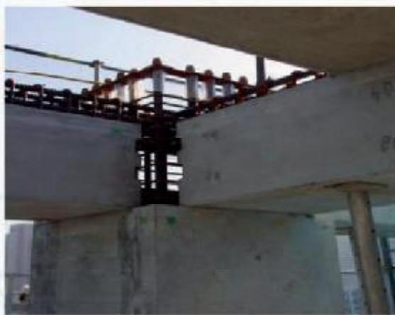
فشاری ۶۵ مگاپاسکال برای اتصال مکانیکی نوع ۱ و حداقل مقاومت فشاری ۷۷ مگاپاسکال برای اتصال مکانیکی نوع ۲ آئین نامه ACI ۳۱۸ باشد.
