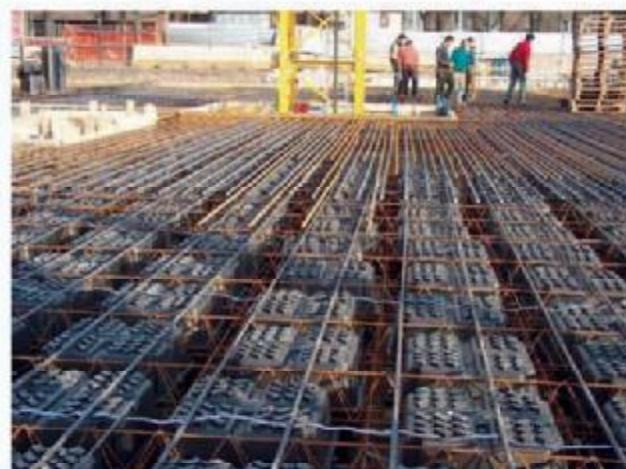
استفاده باشد و همچنین در مقایسه با دال‌های مشابه از وزن کمتری برخوردار باشد، می‌توان به شیوه جدیدی در روش اجرای دال‌های بتن مسلح دست یافت.
