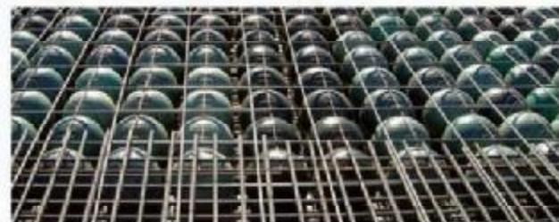
در روند اجرای سیستم سقف کوبیاکس، ابتدا پس از آرماتور گذاری لایه زیرین، قسمه هایی از گوی های کروی شکل با فاصله کنار هم روی شبکه آرماتور زیرین قرار گرفته و پس از آرماتور بندی لایه فوقانی، بتن روئی
