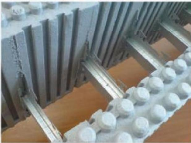
منبسط شونده گند سوز و نوبور تولید می شوند. برای اتصال طرفین قالب از رابطهای فلزی استفاده می شود. اتصال این بلوکها در ارتفاع و در طول با استفاده از کام و زبانه تعیه شده در بلوکها انجام می شود. در زمان بتن ریزی به منظور نگهداری قالبها و ایجاد داریست برای اجرای طبقات بالاتر، لازم است در فواصل مناسب پشتیند اجرا شود. این روش اجراء در مرکز تحقیقات ساختمان و مسکن، مورد ارزیابی قرار گرفته و کاربرد آن در حیطه الزامات ارائه شده، مجاز می باشد.
