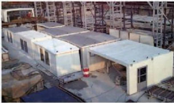
سیستم سازه های بتن مسلح پیش ساخته مدولار سه بعدی در زمینه های سازه و زلزله، انرژی، حریق و آکوستیک در این مرکز مورد بررسی و تالید قرار گرفته است و اجرای آن در حیطه الزامات تعیین شده مجاز می باشد.
