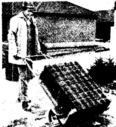
شکل ۹. حمل بلوک با فرغون مخصوص
